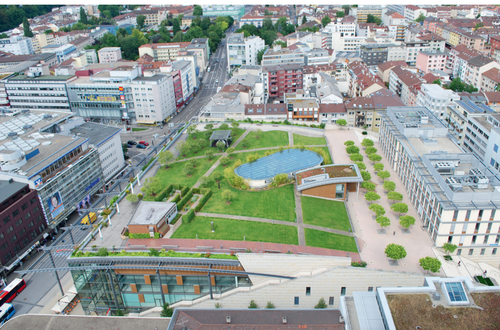
(10) Öffentlich zugängliches begrüntes Dach im Zentrum von Pforzheim. Klimatisierung des Gebäudeinneren, Nutzung der Natur auf dem Dach
