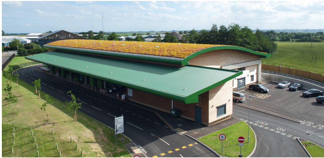
(4) Dachbegrünungen kühlen das Gebäude und deren Umgebung durch die Verdunstung der Vegetation
