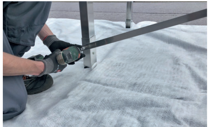
Abbildung 28: Befestigen des Metallstreifens.
