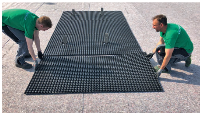
Abbildung 3: Verlegung zusätzlicher FKD 25 ohne Bodenplatte zur Herstellung des Abstandes laut Verlegeplan.
