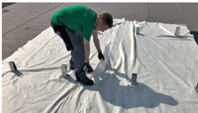
Abbildung 17: Vliesreihen mit Handlötblei verkleben.
