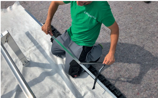
Abbildung 27: Entfernen der Schutzfolie des Windverbandes.
