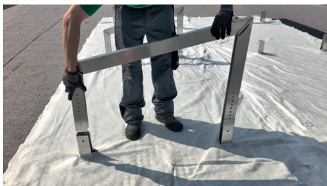
Abbildung 19: Installation des Bügels auf der Bodenplatte (Beispielbügel).
