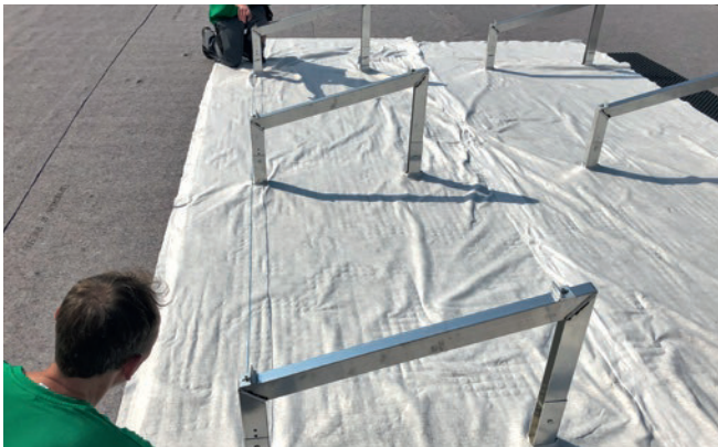
Abbildung 21: Ausrichten der Reihe mithilfe einer Schnur.
