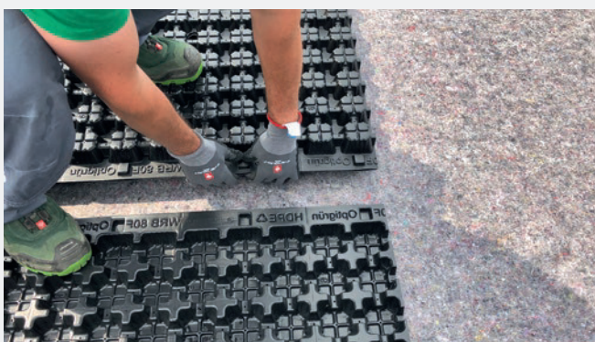
Abbildung 9: Klicksystem schließen.
