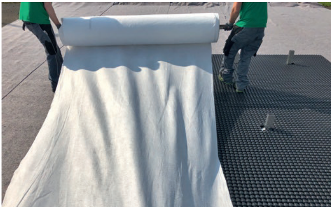
Abbildung 10: Ausrollen des Filtervlieses.
