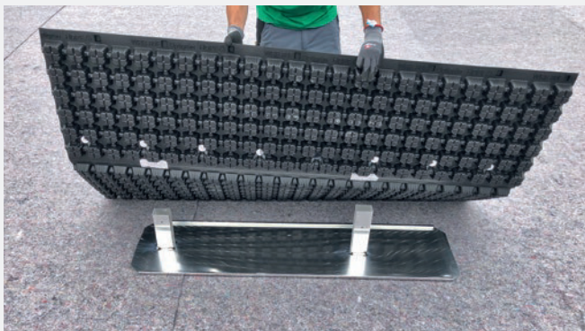
Abbildung 5: Auslegen der Bodenplatte mit WRB 80FMA.
