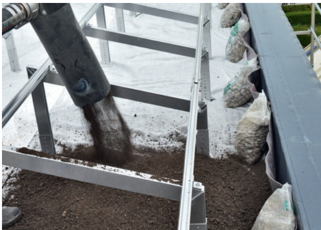
Abbildung 33: Aufblasen des Substrats.
