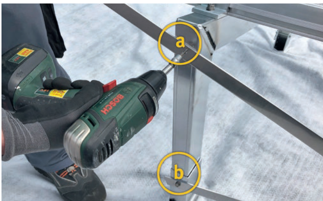
Abbildung 29: Position der Bohrlöcher
