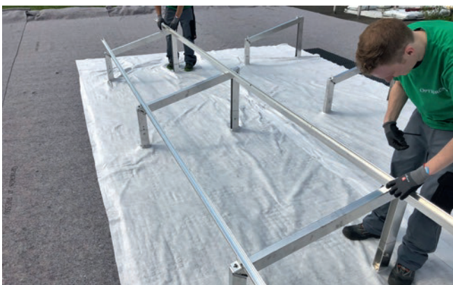
Abbildung 23: Einhängen der zweiten Modulschnellmontageschiene.
