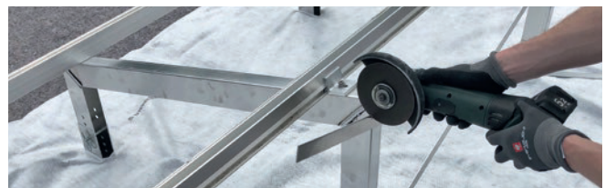
Abbildung 30: Abschneiden des Überstands bei dem Windverband.
