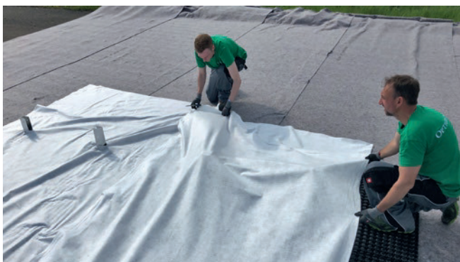
Abbildung 16: Zweite Vliesreihe verlegen.
