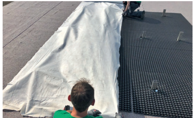
Abbildung 11: Filtervlies glattziehen.
